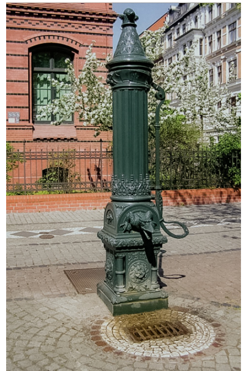
Bild 17: Brunnen mit Schwengelpumpe, wie er u. a. in Magdeburg und Berlin als Notbrunnen deklariert ist. Mit einer Förderleistung von ca. 1.200 Liter pro Stunde könnte er innerhalb von 12 Stunden den Minimalbedarf von 900 Menschen decken. Sein Versorgungsgebiet dürfte wohl die zehnfache Einwohnerzahl enthalten. Quelle: [31]
