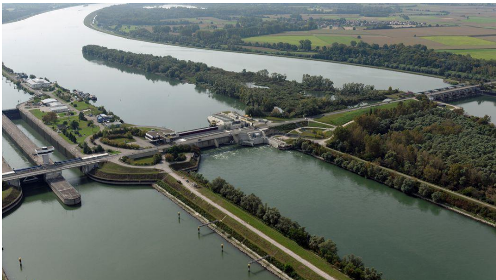
Bild 11. Das 2013 ausgebaute Rheinkraftwerk Iffezheim (Foto: EnBW/Daniel Meier-Gerber)
