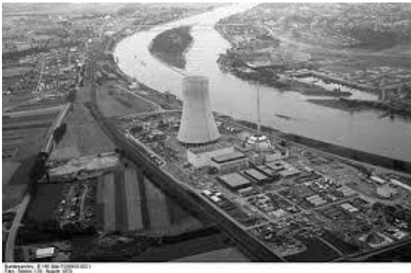
Bild 85. Luftbild des Kernkraftwerks im Jahr 1979 während der Bauzeit 164 Bundesarchiv, B 145 Bild-F056650-0021 / Engelbert Reineke / CC-BY-SA 3.0
