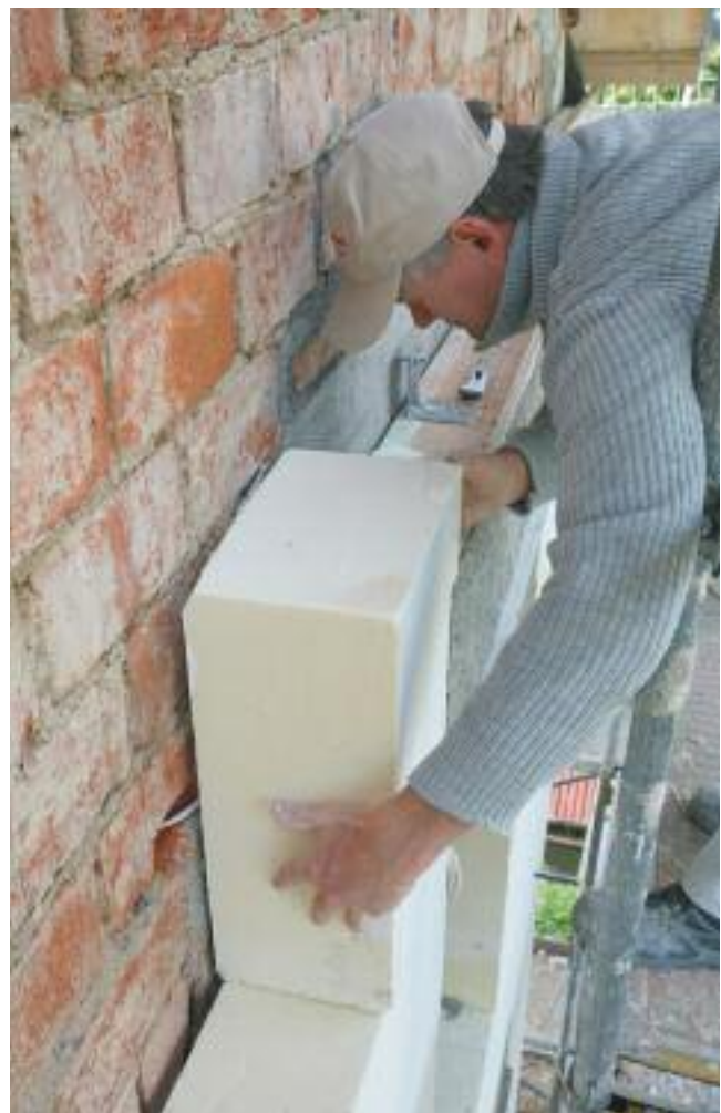
Dämmmaterialien werden am Tag extrem heiß, blockieren aber das Einspeichern der Sonnenwärme ins Mauerwerk.
