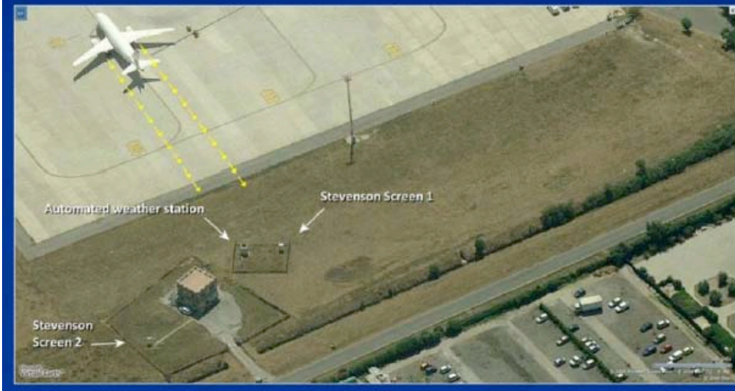
Abbildung 8 zeigt die Temperaturmessstation auf dem Flughafen von Rom und dessen Lage zum Rollfeld.
