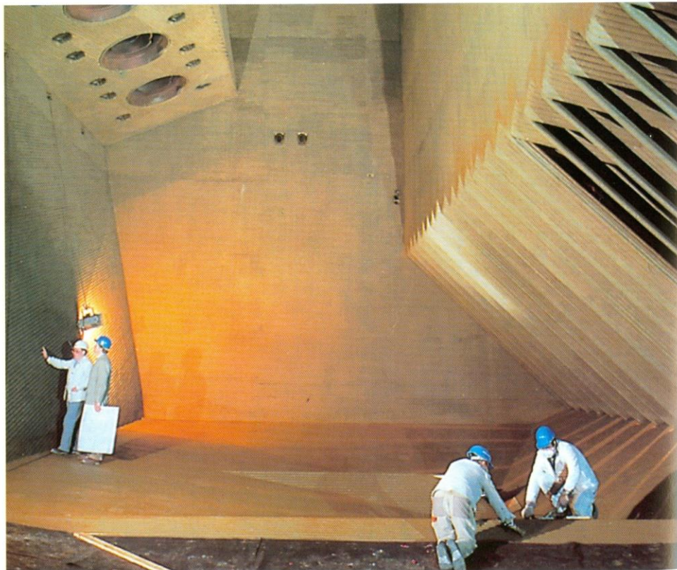
Stufenschmelzkammer eines 770 MW Dampferzeugers (um 1990).
