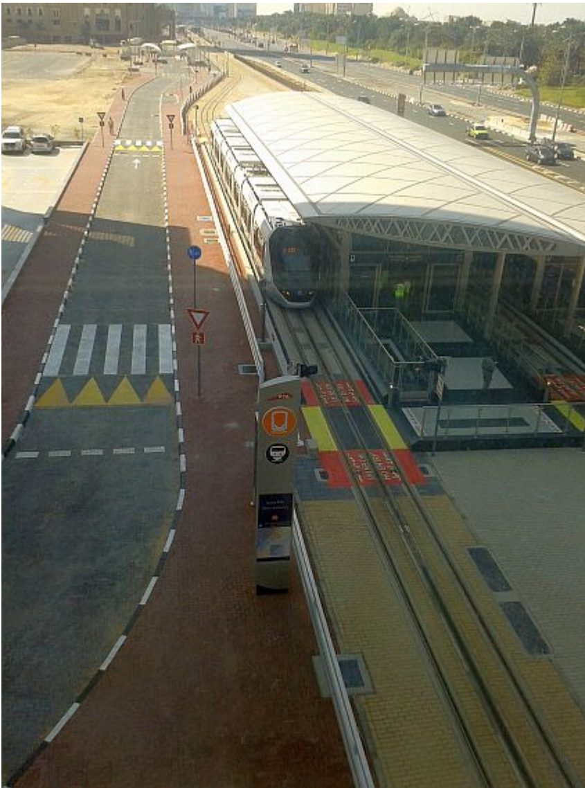
Demmig, Straßenbahn in Dubai mit Stromband in der Mitte der Schiene
