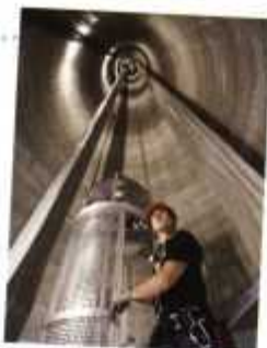
Im Turm einer Windenergieanlage
