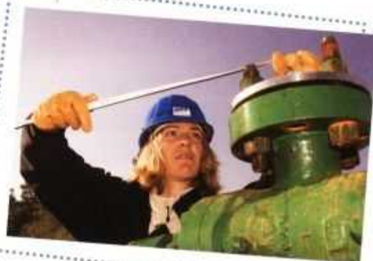
Technikerin überprüft Ventil (Geothermiebohrung)
