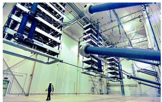
Erdbebensicher aufgehängt: Die Thyristoren für die 600 MW HGÜ-Verbindung zwischen Australien und Tasmanien.
