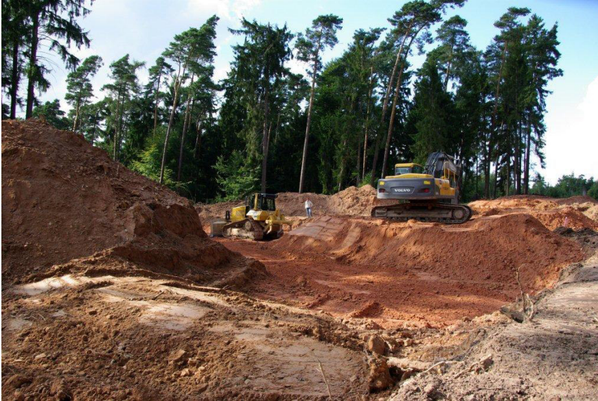
Abb. 35: Für die seit Kurzem in zahlreichen Bundesländern begonnene Errichtung großer Windkraftanlagen in Wäldern werden große Waldbestände zerstört, um die riesigen Bauteile an ihren Standort zu bringen. Hier eine solche Baumaßnahme im Odenwald.
