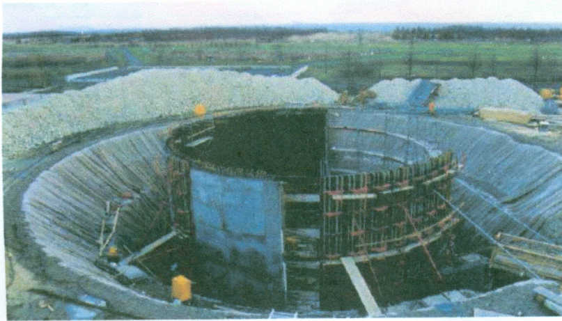
Abb. 40: Speichertank der Anlage in Hannover – Volumen 2750 m 3 - im Bau. Quelle: High-Combi-Report (60)
