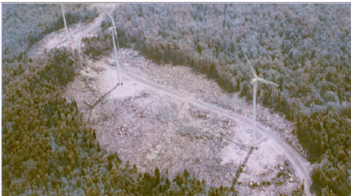
Abb.35b: Kahlschlag für den Klimaschutz. Die Luftaufnahme eines Waldstücks, in dem mehrere Windkraftanlagen errichtet wurden, zeigt das Ausmaß der bereits für einzelne Anlagen angerichteten Zerstörung. Dabei sind die für den Transport der Bauteile neu angelegten breiten Zufahrtsschneisen hier noch nicht sichtbar – Abb.35 vermittelt davon einen Eindruck.
