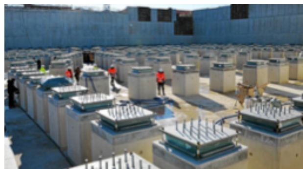
Abbildung 11 Dämpfung des 2 m hohen Reaktorgebäudes mit Schwingung
