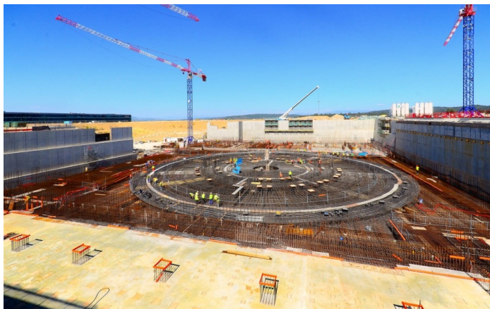
Abbildung 12 erdbebensicheres Fundament zur Aufnahme des 360.000 to. schweren Fusionsreaktors
